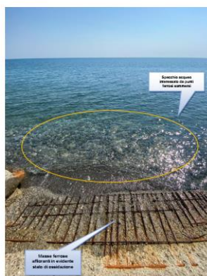
Foto 3: masse ferrose affioranti in evidente stato di ossidazione
