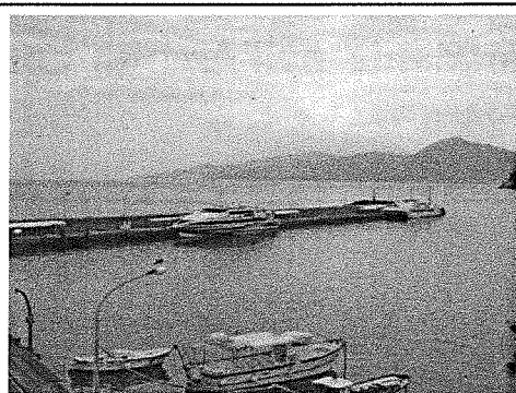
Porto commerciale: banchina principale o “molo di sopraflutto” destinata all’ormeggio di unità navali di linea
